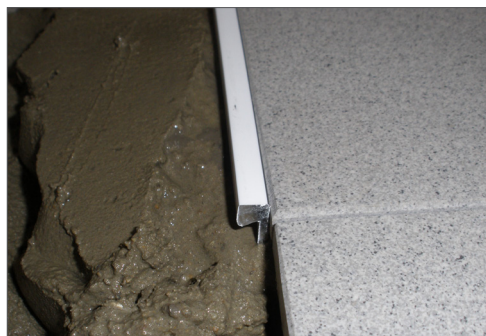
Mise en place Novosepara 1
