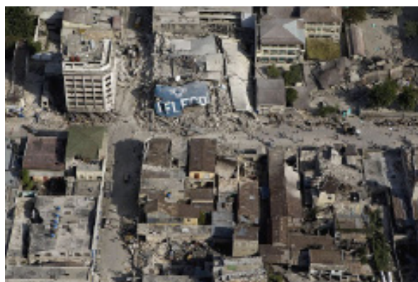
Immeubles détruits par le séisme de Haïti. Port au Prince. An 2010. Source Wikipedia.
